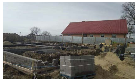
Budowa szkoły podstawowej w Tuchomiu
