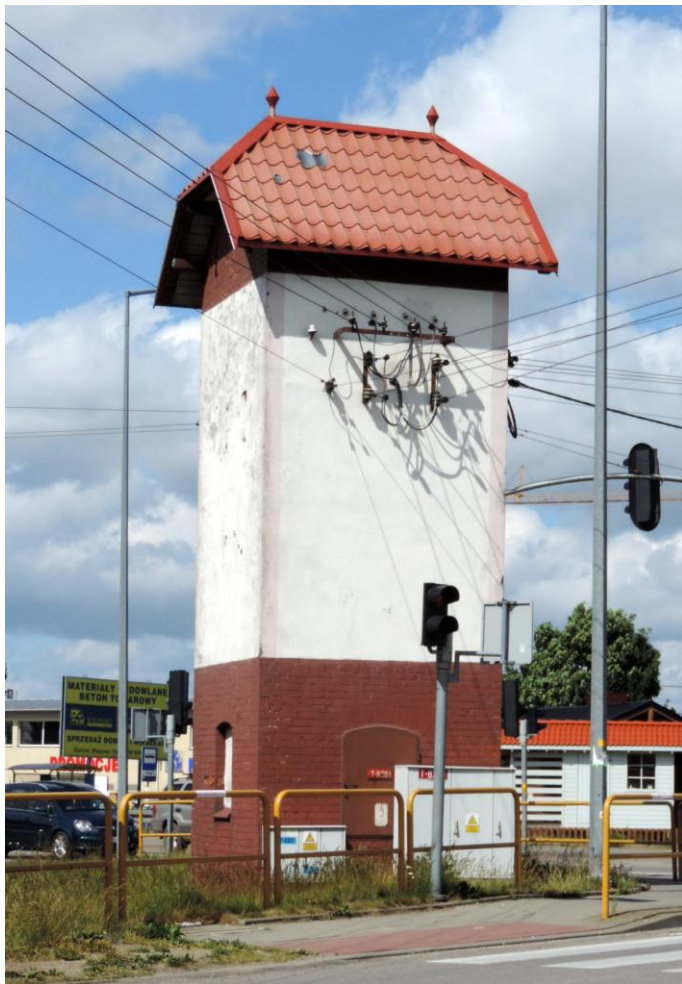
Widok od południowego-zachodu
